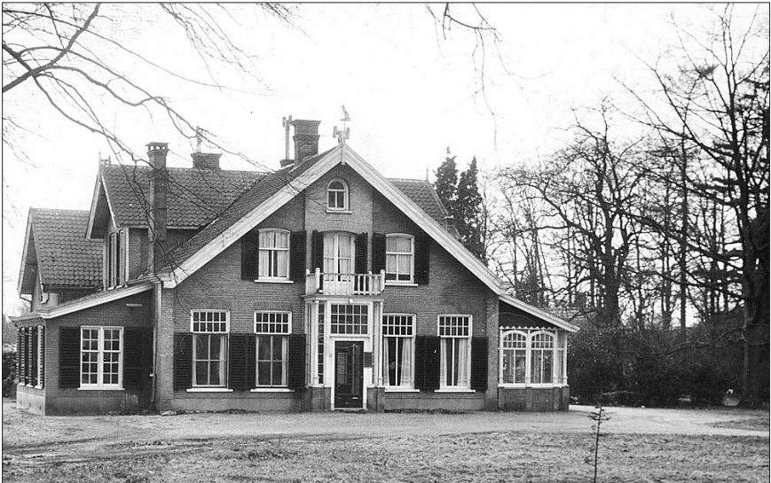
Villa De Honskamp werd gesloopt.
